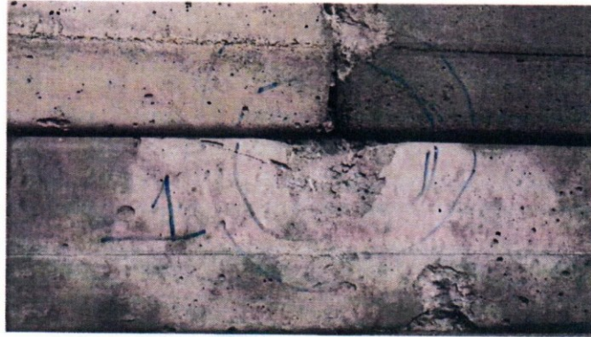
10 metreden atış sonrası duvardaki durum
