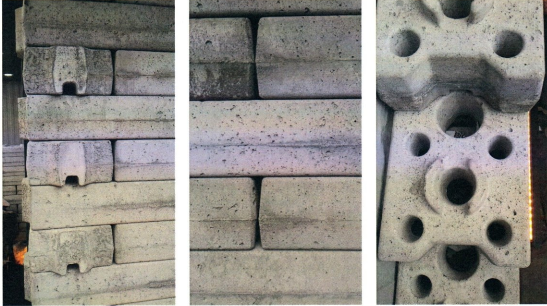
Fotoğraf-2: İncelemeye konu duvar elemanları ile yapılan duvara ait bazı detay fotoğrafları
