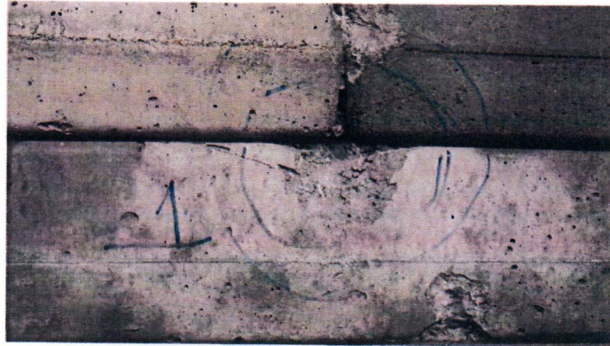
10 metreden atış sonrası duvardaki durum
